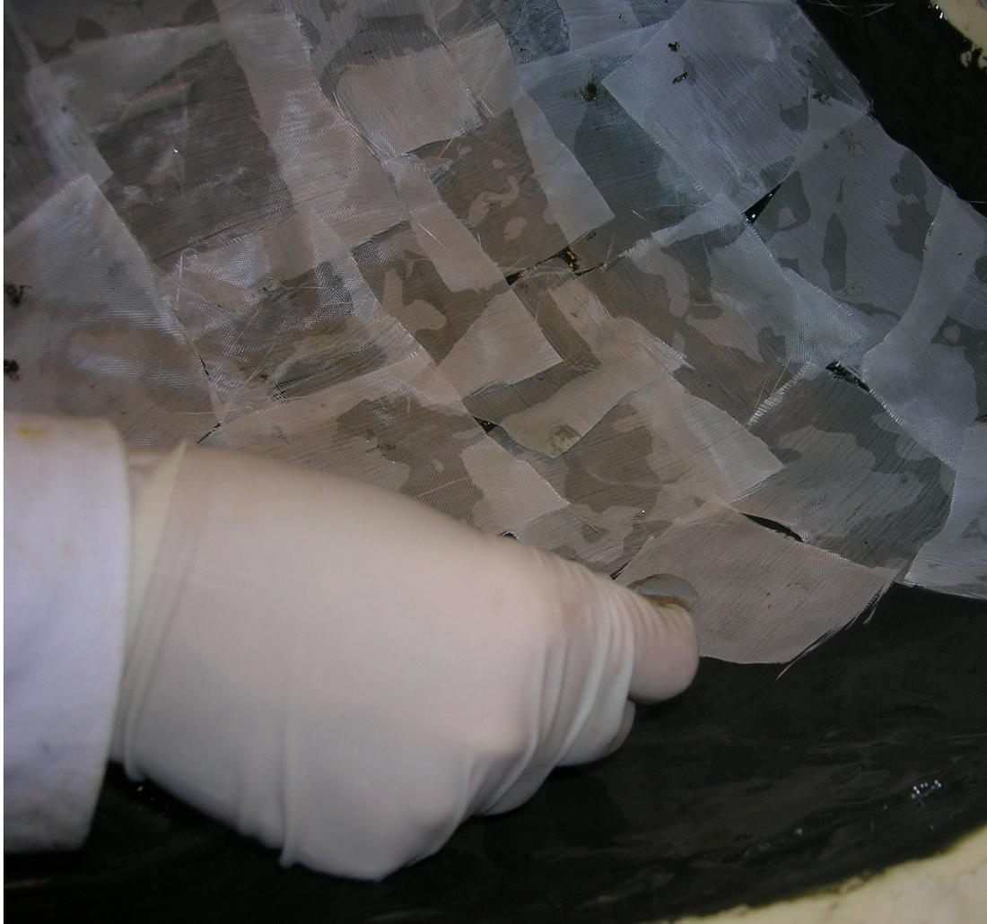
applicazione delle porzioni di tela di vetro sul primo strato di resina epossidica
